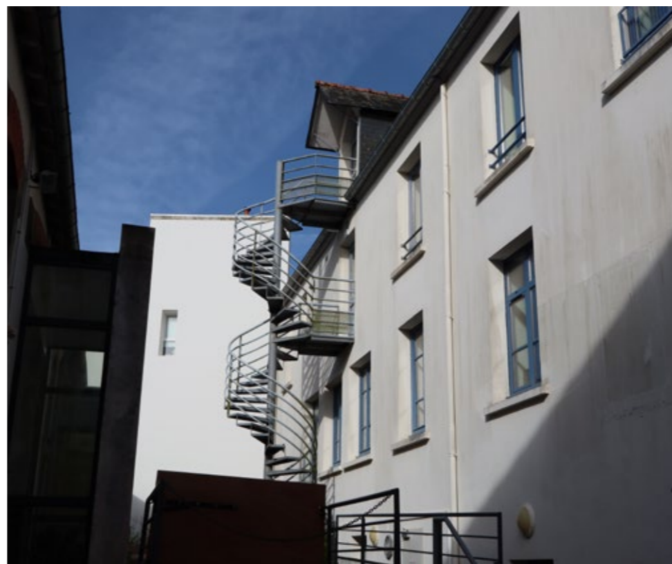
Vue de la façade arrière de la mairie et des escaliers de secours en façade de celle-ci
