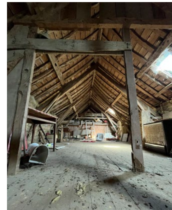
Vue intérieure des combles, la charpente semble assez saine, elle est ancienne.
