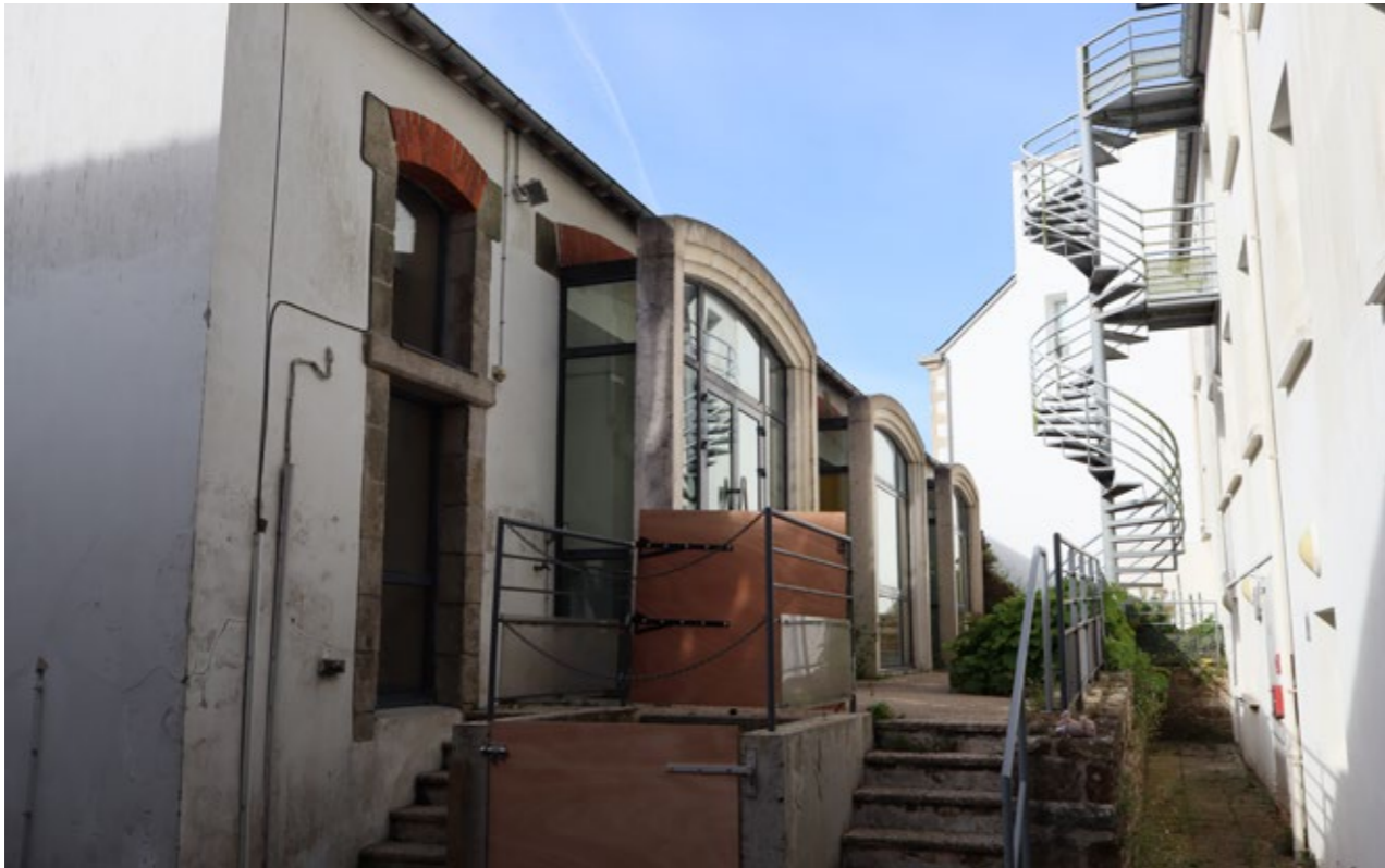
Vue de la façade Nord du bâtiment sur la place, les ouvertures d'origine ont été réhabilitées et prolongées par des murs-rideaux. A l'est du bâtiment, les accès sont accessibles par des escaliers, et à l'ouest les accès sont de plain-pied.
