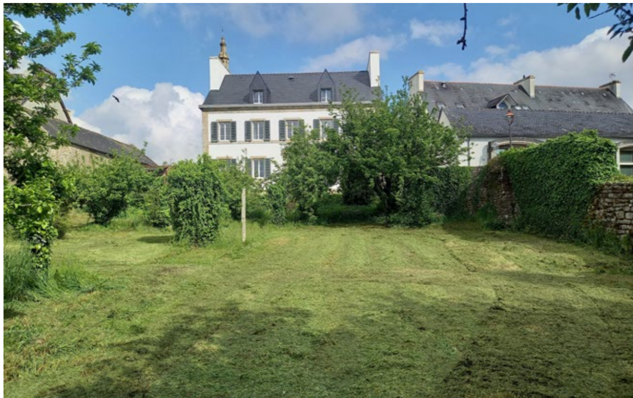
Vue de la façade sur jardin du Presbytère au Sud: la façade à été rénovée avec changements des menuiseries et volets, rénovation et remise en enduit, toiture refaite. Le bâtiment domine le jardin.
