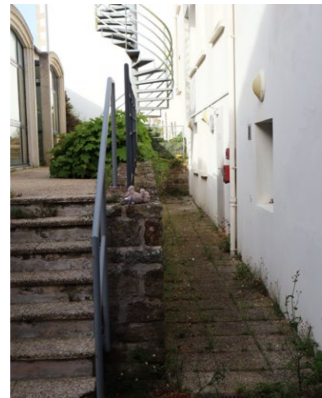
Vue de la façade arrière de la mairie et de la venelle, on voit l'accès au locaux en sous-sol
