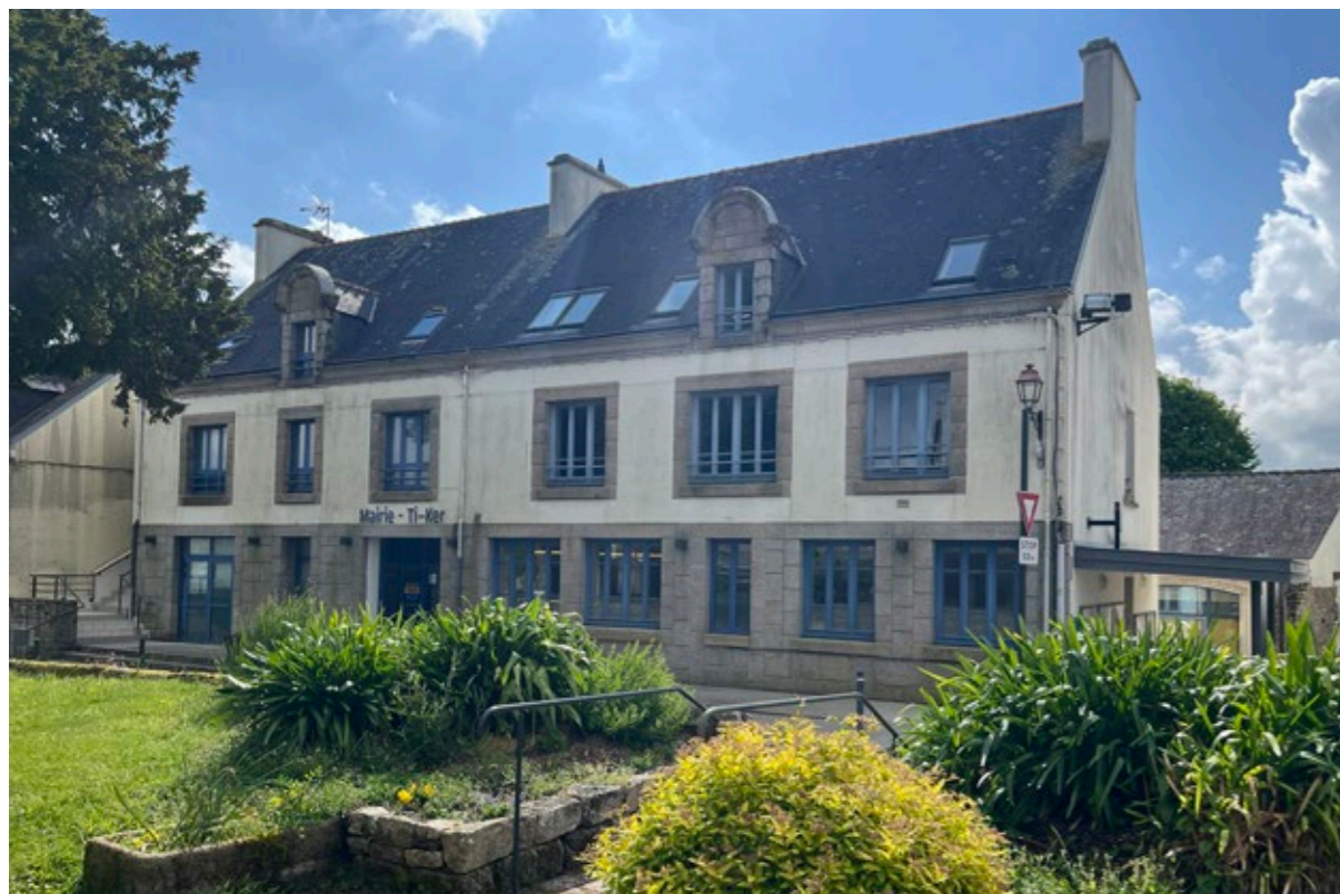
Vue de la façade avant de la mairie sur rue : trame de façade régulière, encadrements granit des fenêtres
