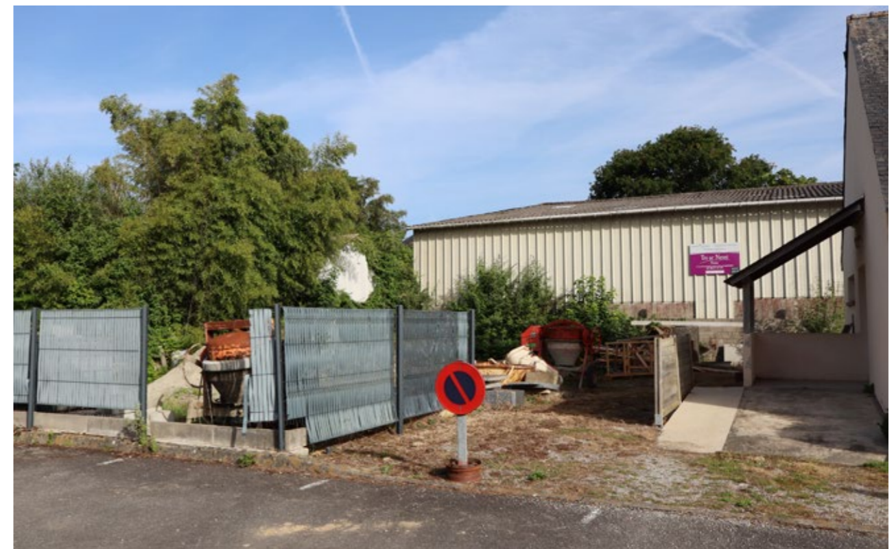
Les abords du bâtiment au sud sont encombrés par du matériel.
