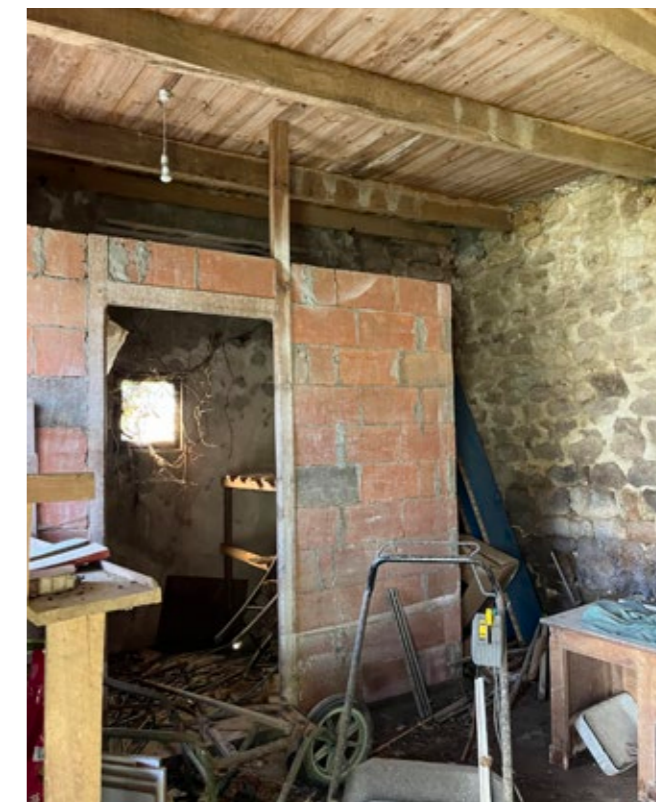
Vue intérieure de la pièce côté jardin, qui donne accès aux combles. Les murs en pierres sont en bon état.
