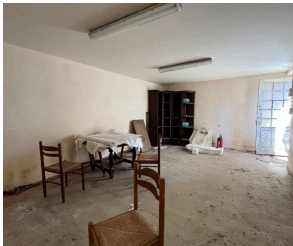
Vue intérieure de la pièce centrale, des doublages ont été réalisés et la pièce est alimentée en électricité. Pas d'accès aux combles.
