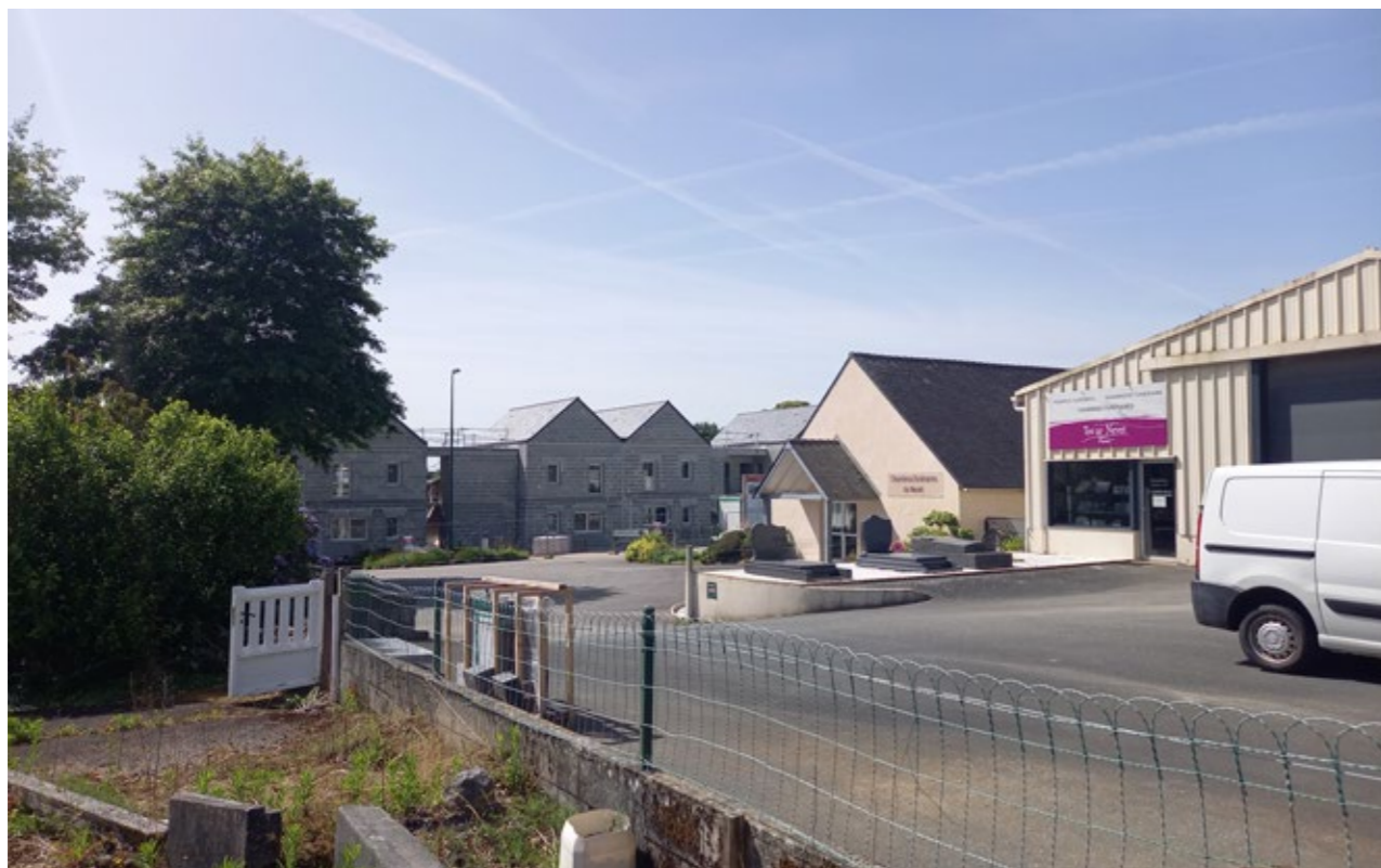
Vue des bâtiments funéraires depuis la parcelle de la maison Kéval.
