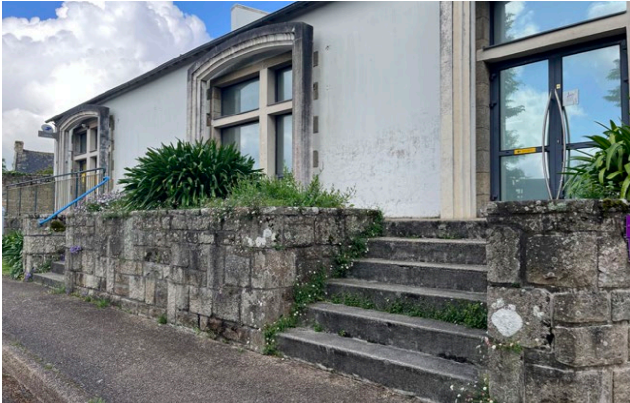
Vue de la façade Sud du bâtiment sur la place, on voit que les encadrements pierres des ouvertures ont été habillés par des encadrements béton. Le bâtiment est sur un socle, les accès sont accessibles par des escaliers.
