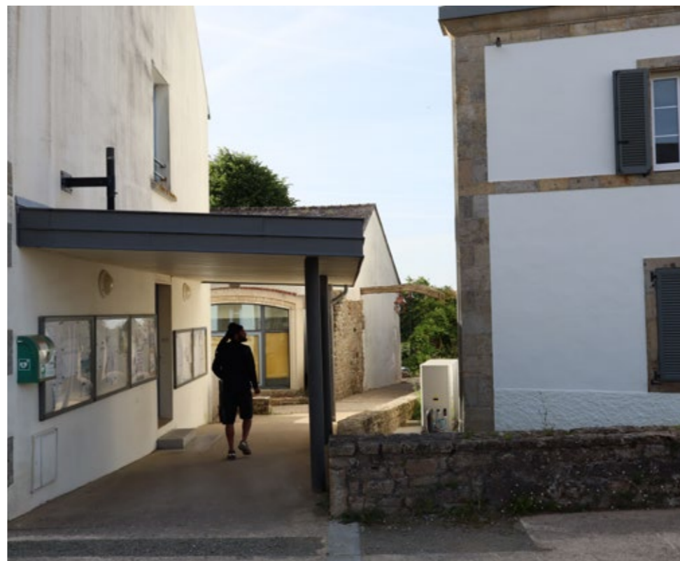
Vue du passage entre la mairie et le presbytère avec l'auvent sur le pignon qui sert d'espace d'affichage
