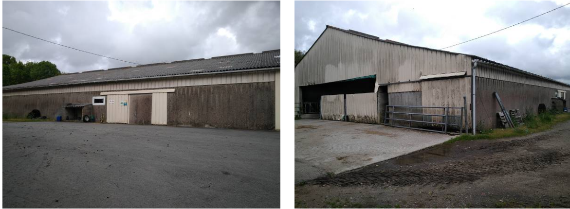
Vues du bâti concerné
