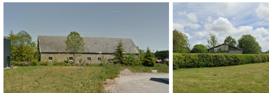
Longère en pierre et hangar en ruine (Google Maps)
