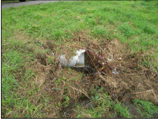
Exutoire du bassin de rétention Landibilig
