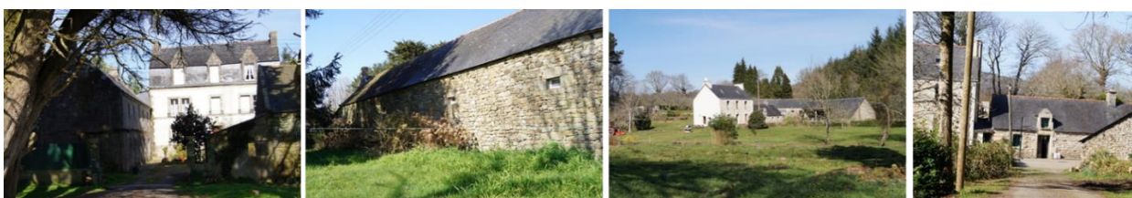
Un bâti sous forme de longères, RDC + combles, aux volumes allongés – parfois des logements de fonction avec un étage supplémentaire.
